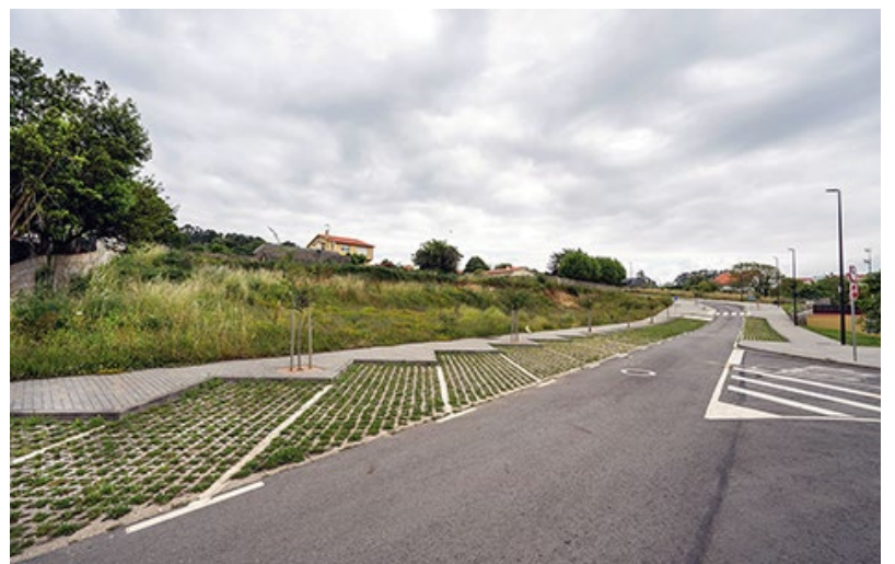
■ As vivendas de Mera estarán no centro da nova urbanización, na rúa Eduardo Galeano, fronte ao monumento ao profesorado
