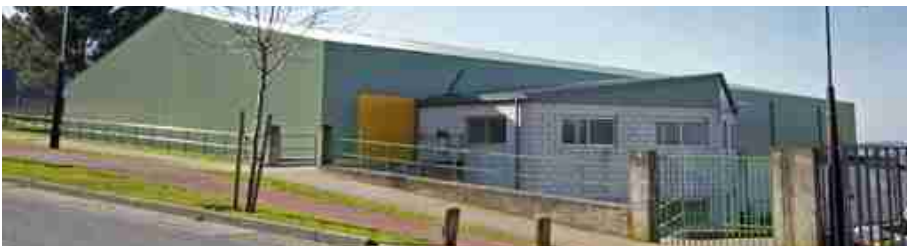
▲ Polideportivo municipal de Canide: avenida María Pita, 27
