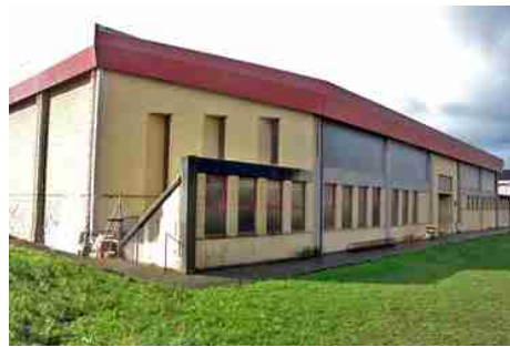
▲ Polideportivo municipal de Perillo: avenida Valle Inclán, 26
