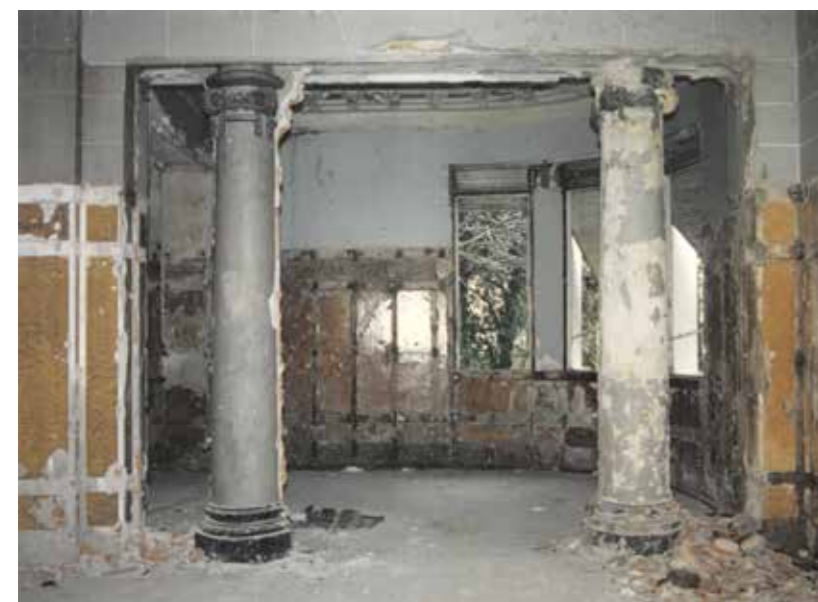
Detalle da situación do edificio antes da restauración
